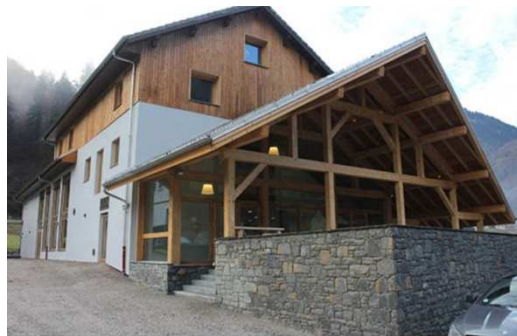
17 janvier : Inauguration de la rénovation de la Salle des fêtes « La Reine des Alpes » à Sixt-Fer-à-Cheval
