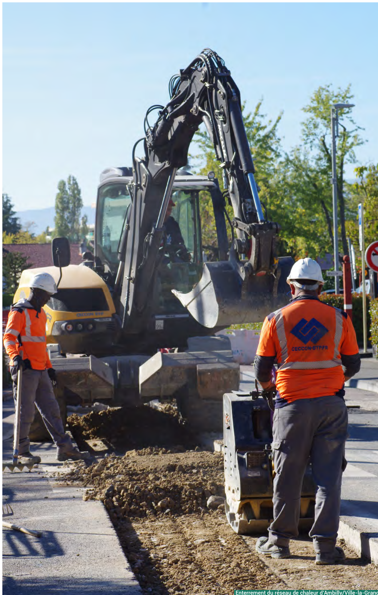
Enterrement du réseau de chaleur d'Ambilly/Ville-la-Grand
