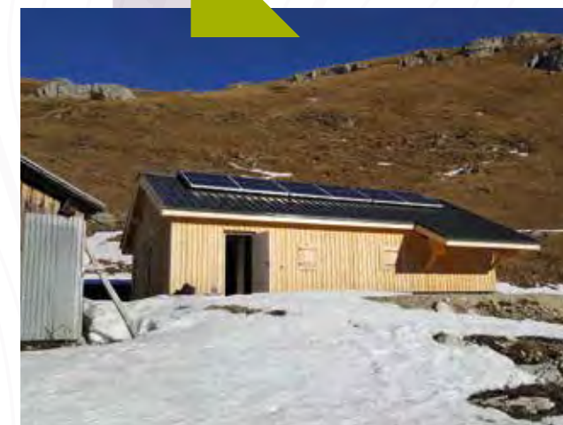
Des panneaux photovoltaïques ont été installés sur la toiture de l'alpage.
