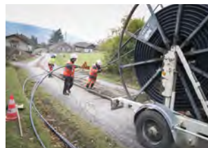
Construction du réseau public de fibre optique
