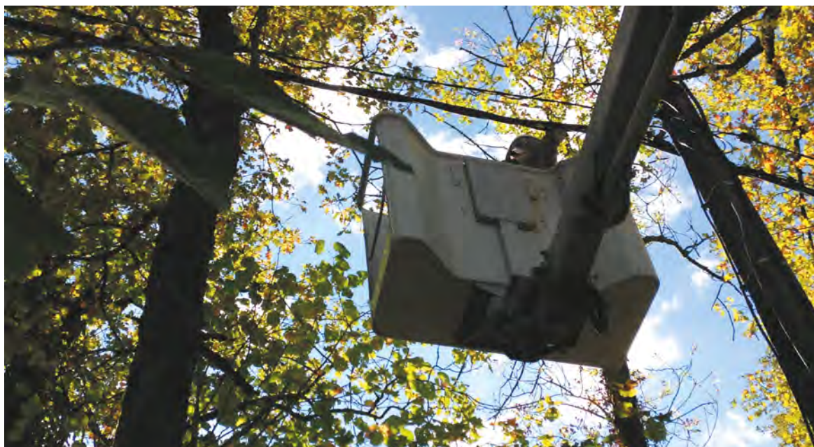
Travaux de rénovation à Amancy
