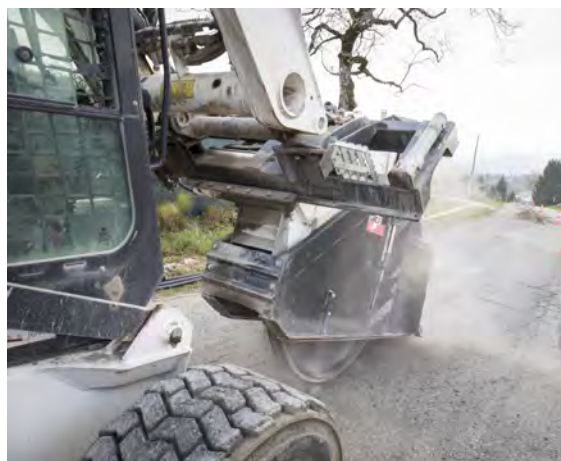
Construction du réseau de fibre optique à Groisy
