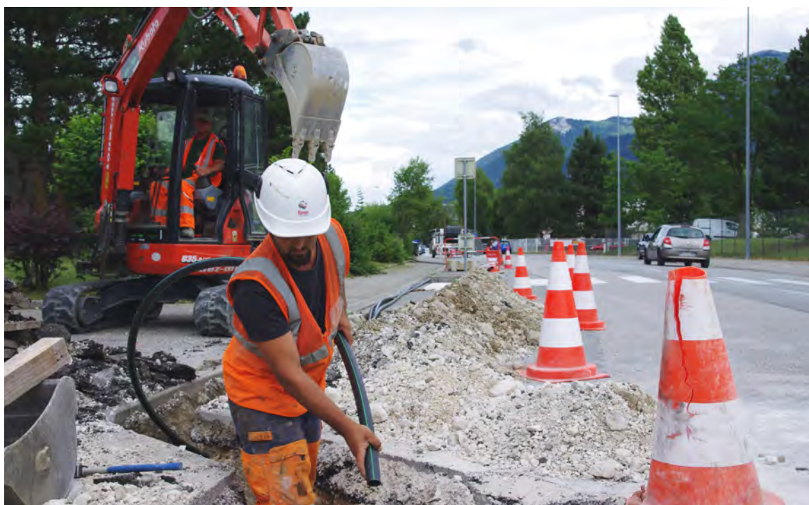
Construction du réseau public de fibre optique pour les professionnels à Annecy-le-Vieux (Parc des glaisins)
