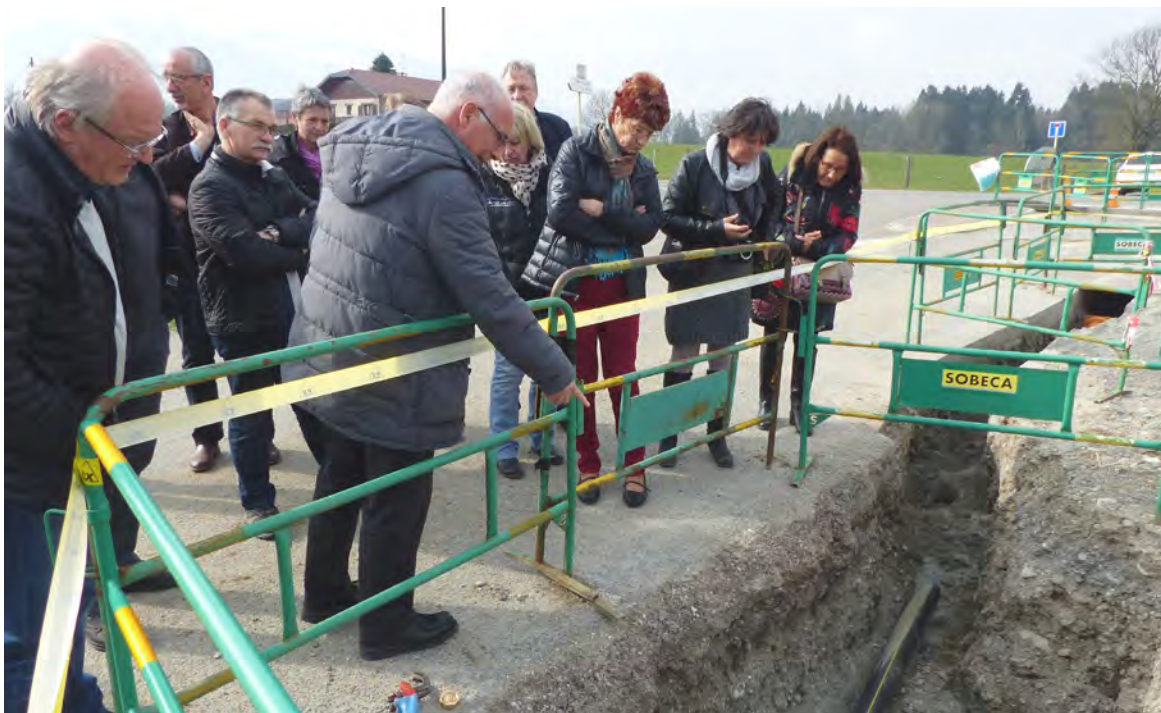
Arenthon : visite du chantier avec les élus locaux et GRDF
