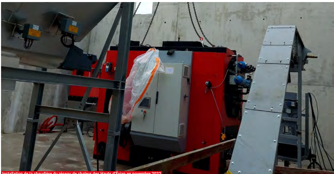
Installation de la chaudière du réseau de chaleur des Hauts d'Évian en novembre 2022
