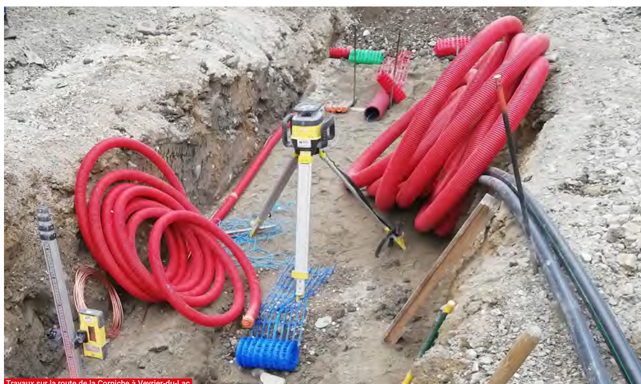
Travaux sur la route de la Corniche à Veyrier-du-Lac
