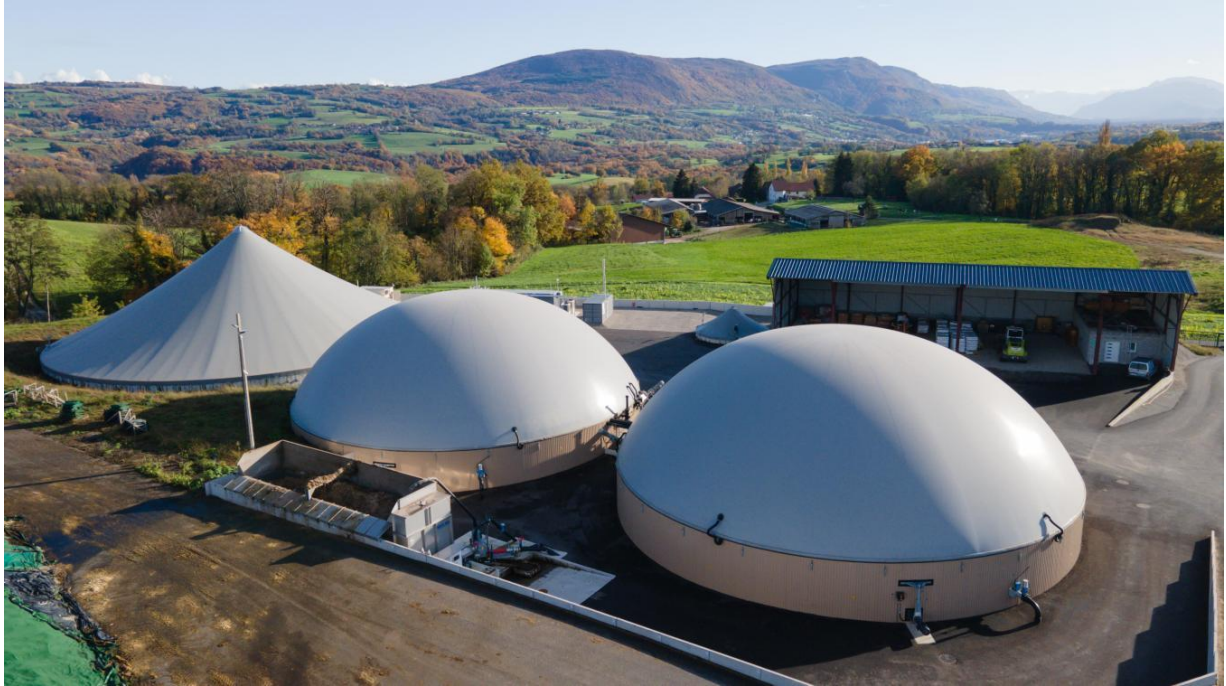
Figure 4 : Méthaniseur agricole en injection (Bassy 74910)
