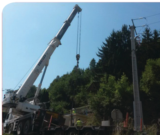
Le coût prévisionnel des travaux sur le réseau 20 000 Volt, financés en totalité par Enedis, s'élèveront à près de 500 000 €.
