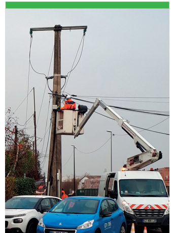
Pose de Fibre Optique sur supports électriques
