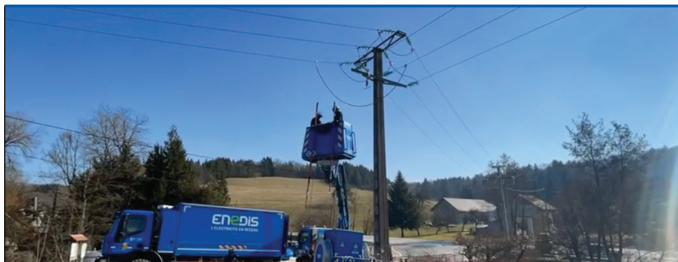
Pose d'un interrupteur HTA sur la commune de MESIGNY (74)
