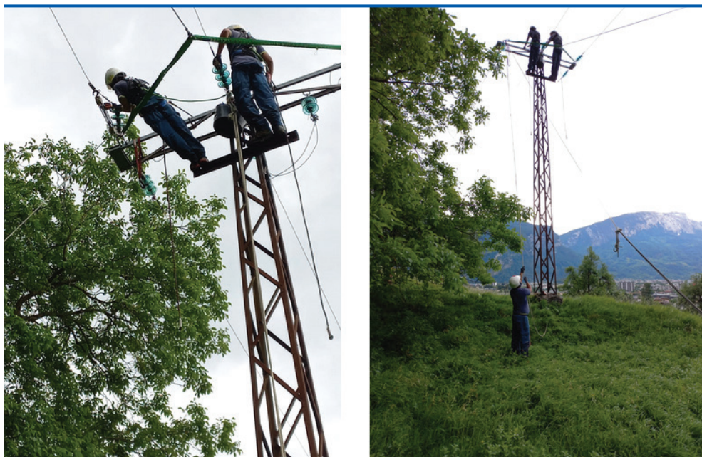
La formation de nos jeunes agents sur le terrain avec un chantier école d'élagage à CLUSES
